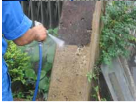
塀の汚れ、藻の洗浄作業
